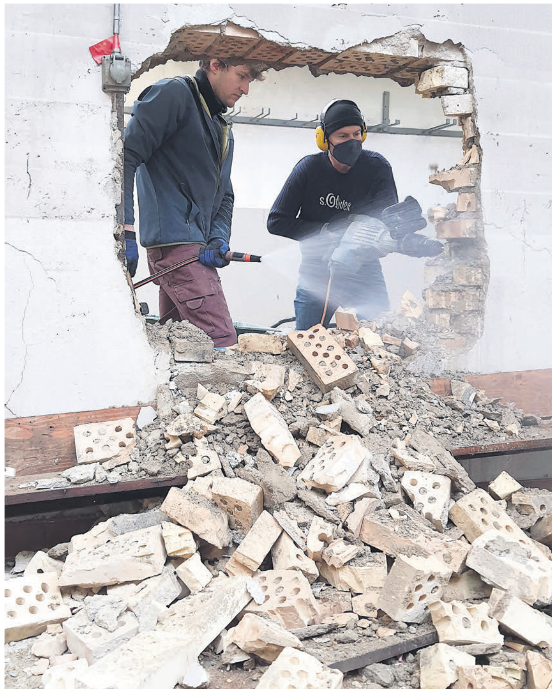
Der grosse Durchbruch ist geschafft: Daniel Renggli (rechts) und Jonas Arnet haben sich mit grossem Aufwand durch eine massive Wand gekämpft.
