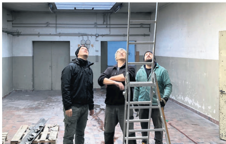
Inspektion der Räume inklusive Dachkonstruktion (v.l.): Manuel Rimann, Stefan Hegi und Maurus Keusch.
